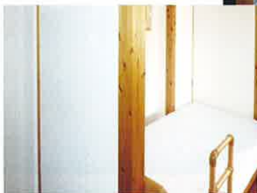
ベッド設置の状態
