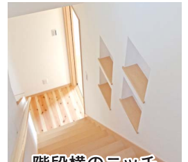
階段横のニッチ
